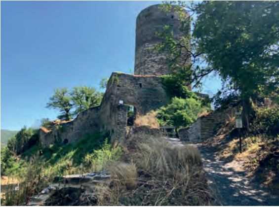
Am äußeren Burgtor: Nach der Sanierung wurden die Mauerkronen mit schützenden Gräsern und Moosen abgedeckt
