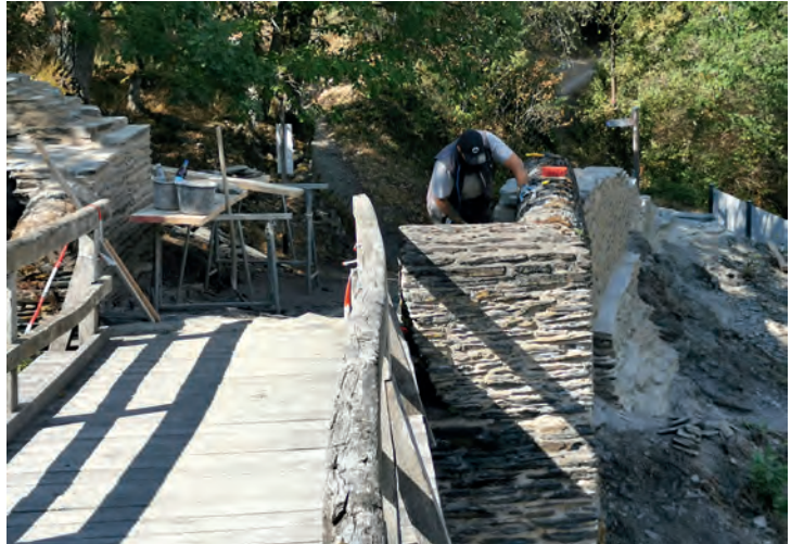
Im Sommer 2022 erfolgte die Sanierung der Mauer am äußeren Burgtor © Dieter Stiehl
