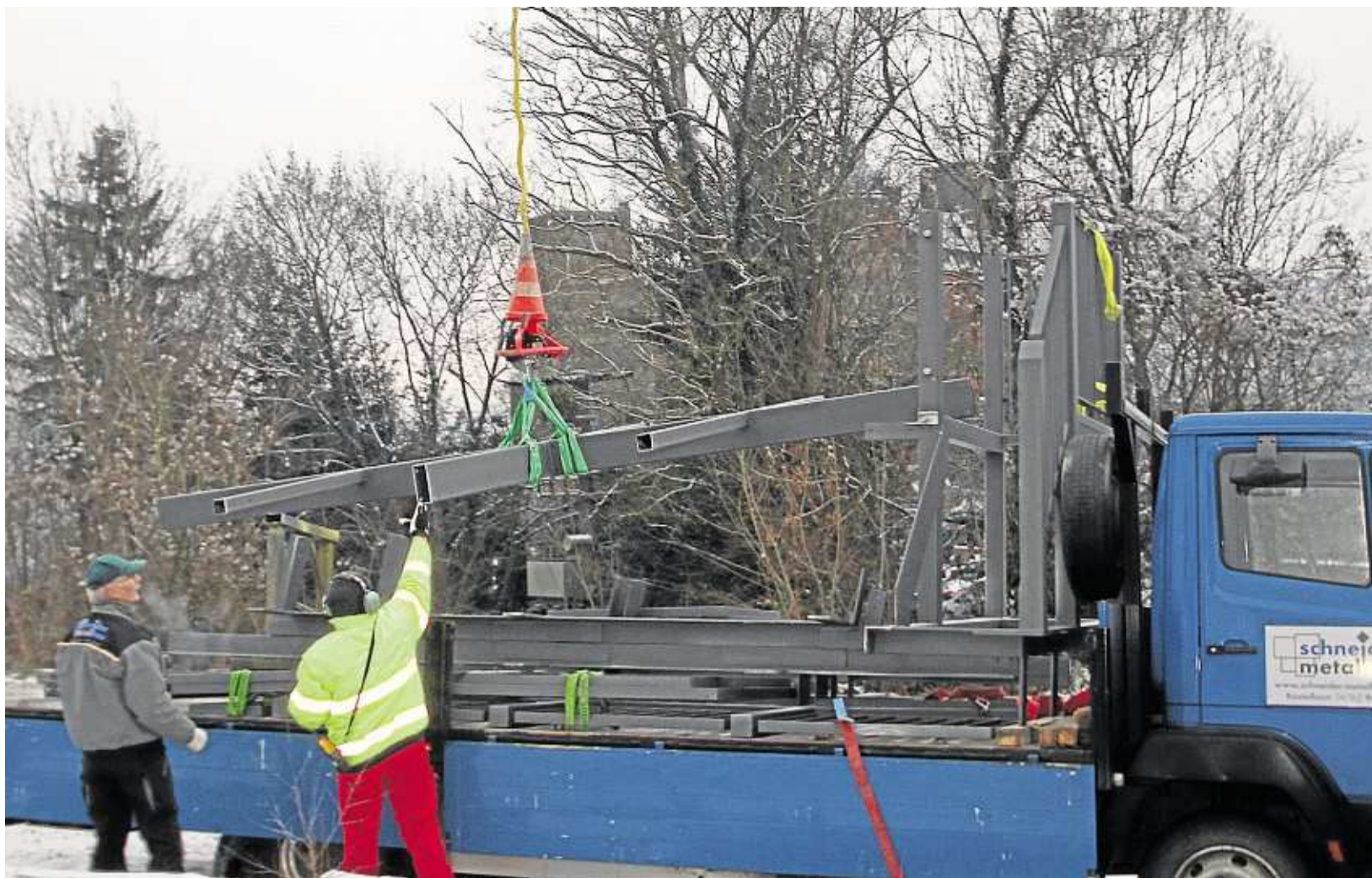
Mit einem spektakulären Hubschraubereinsatz über dem ehemaligen Wehrturm wurden Werkzeuge und mehrteilige Stahlkonstruktionen in das Innere des zukünftigen Museums befördert. Das Gesamtgewicht der Last betrug mehr als zwei Tonnen.
